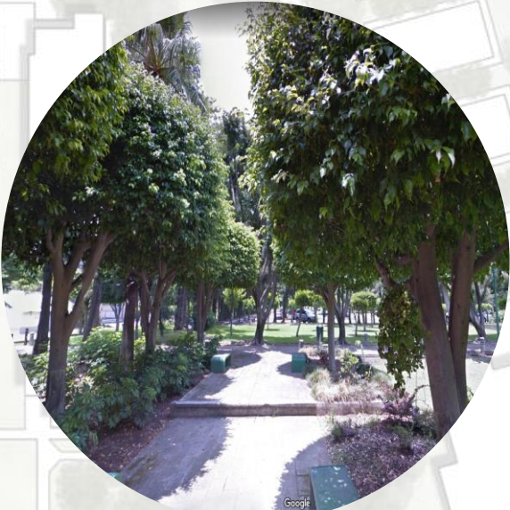
Deterioro de caminamientos
